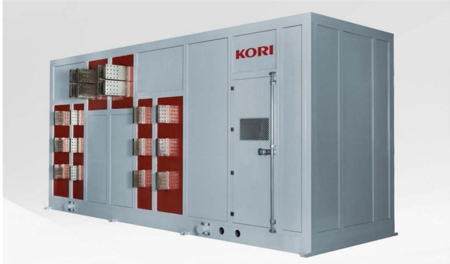
在储能的世界中，绿电制氢一直是业内关注的对象，无论是国内还是国外。单台4000标方（Nm<sup>3</sup>/h）的绿电制氢电源，即将发往美国CFI（CF Industries Holdings）氨工厂。制氢电源是绿电制氢工艺的“心脏”，技术难度非常高，结构也非常复杂。这台设备的厉害之处，在于把所有设备都集中在了一个柜体里面。集成化设计提高了元器件运行环境的恒定和电源的使用寿命，施工周期也从原来的几个月缩短到了几天。另外，在制氢过程中，设备持续稳定运转是关键，如果控制器故障导致电流不受控制或者断电等，那么电解槽就有可能短路或者爆炸。而它搭载了最先进的热冗余系统，能在主控制器出现故障的时候，自动、无时滞地切换到备用控制器，不会影响电解槽的正常运转。这些设计和优势都使得科瑞变流的制氢电源成为横扫欧洲的中国高端设备。
